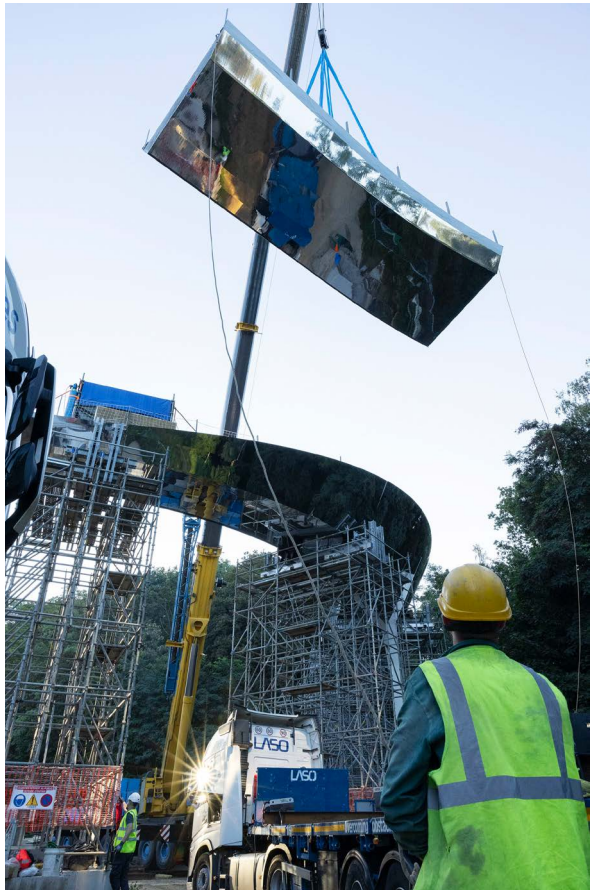
Pose du dernier tronçon
